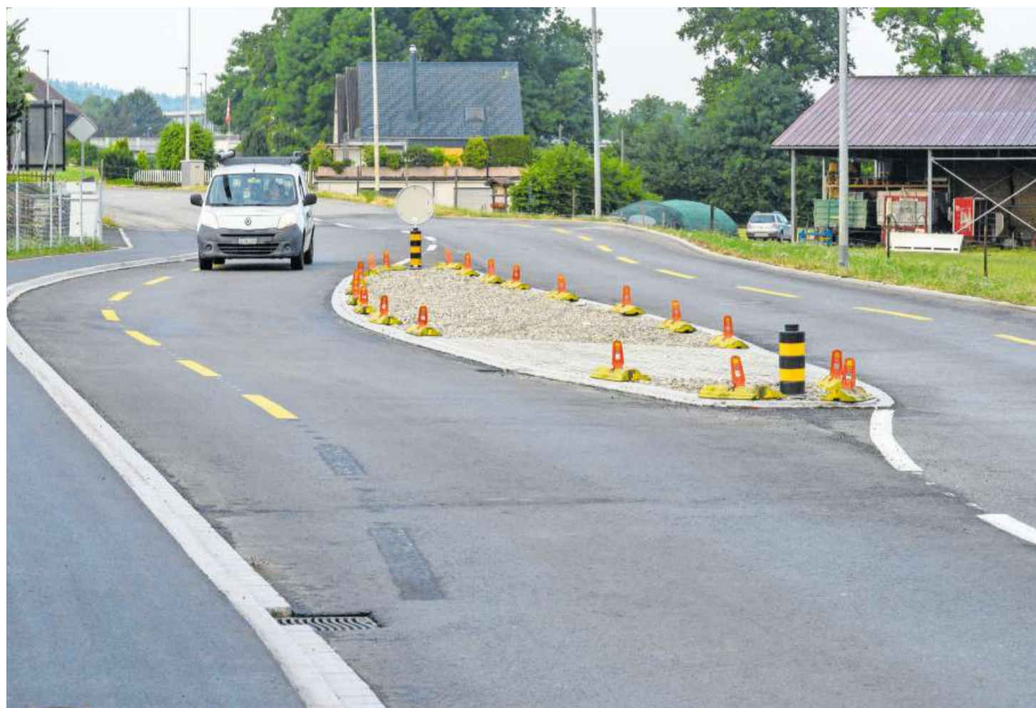
Mittelgäustrasse Gunzgen: deutlich erkennbar die mittlerweile eliminierten Linien des Radstreifens.
