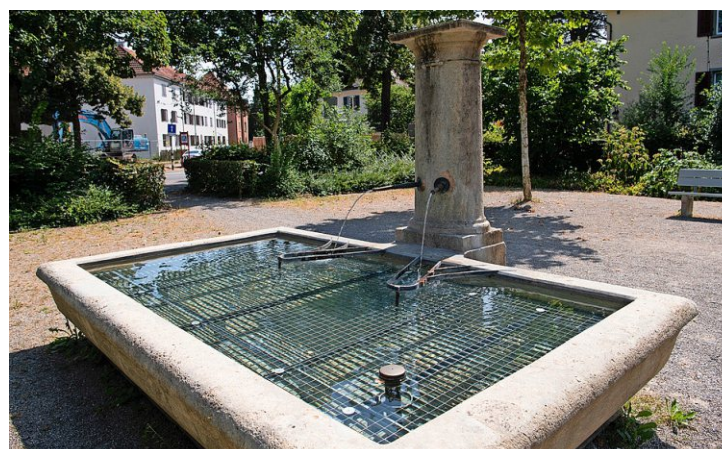
In den Brunnen an der Ecke Thurgauer-/Geiselweidstrasse wurde sicherheitshalber ein Rost eingelegt. Foto: Seraina Boner
